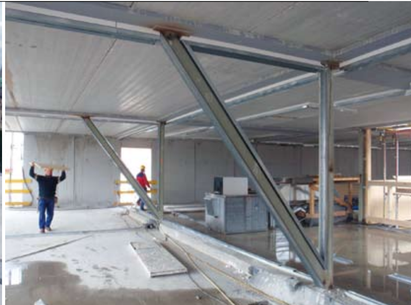
Einige der Vorteile, mit denen das System Deltabeam bei diesem Projekt punktet, sind neben der geringen Bauhöhe und der raschen Montage das unterstellungsfreie Errichten der gesamten Deckenkonstruktion.
