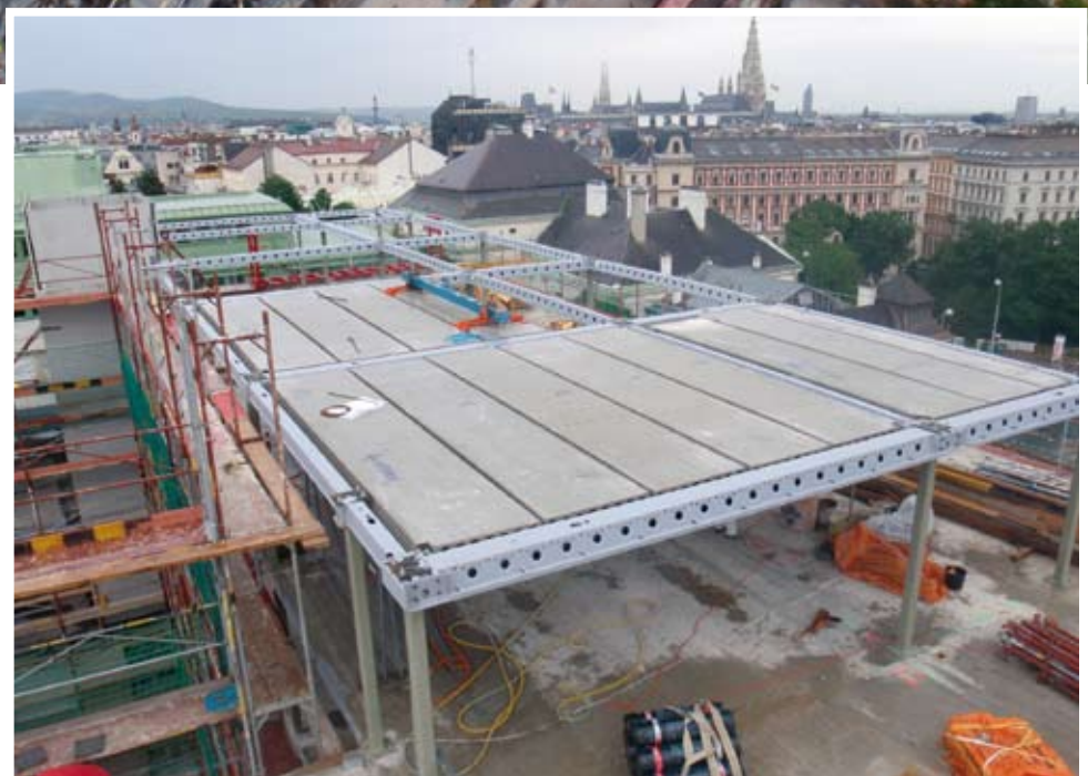
Die Bilder zeigen neben der schlanken Stahlverbundkonstruktion der Aufstockung auch die beengte Baustellensituation.
