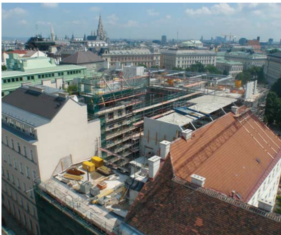
Exklusive Lage: Blick vom Kranausleger auf Höhe Mechitaristengasse Richtung Wiener Innenstadt.
