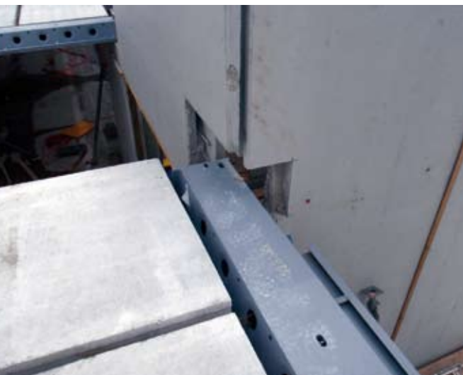
Sicherheit: Auch ohne zusätzliche Brandbeschichtung gilt der Deltabeam als R90-brandbeständig.
