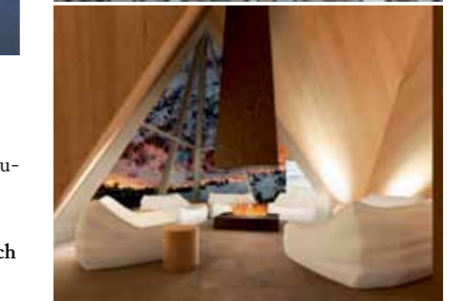
Therme Längenfeld: Aufstockung Sauna als Holz-Faltwerk
